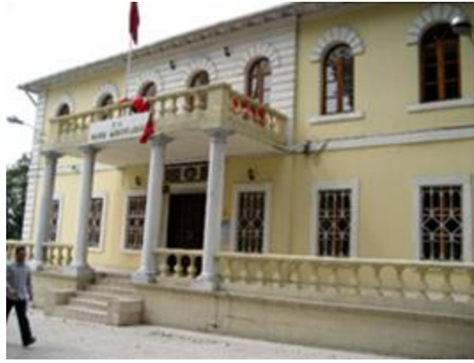
Şekil 2.1.4.2: Fatih Karakolu giriş cephesi (Emine Kırıkçı)
