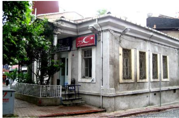
Şekil 2.1.5.2: Fatih Çarşamba Karakolu batı ve güney cephesi (Emine Kırıkçı)
