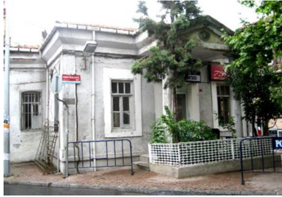
Şekil 2.1.5.1: Fatih Çarşamba Karakolu batı cephesi (solda) (Emine Kırıkçı)
