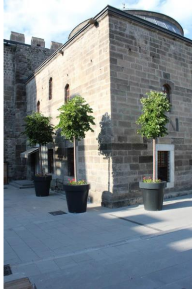
Şekil 6. Saksı ile yapılan peyzaj uygulamaları
