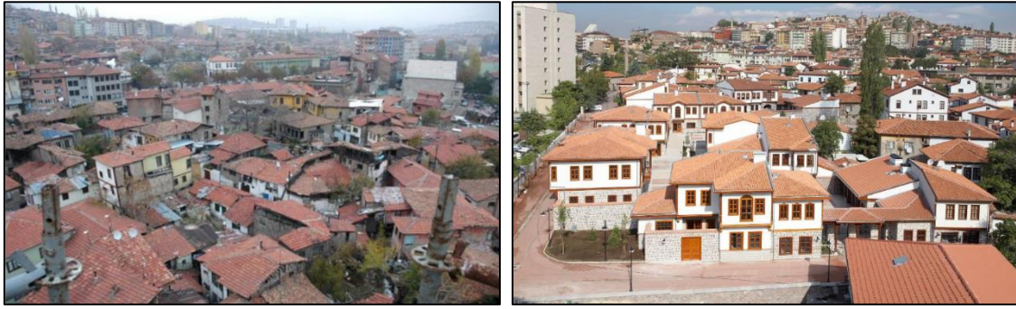
Şekil 2a-b. Ankara Hamamönü Önceki ve Sonraki Hali (Sadioğlu vd., 2016)
