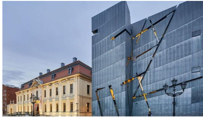
Şekil 3.6: Yapının cephesindeki yırtıklar (URL 2)
